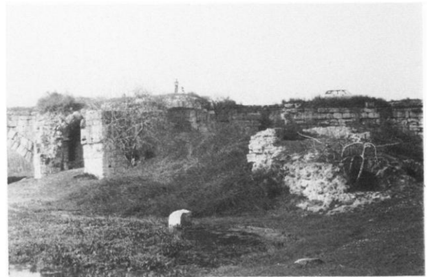
(d) Breakwater from south.
